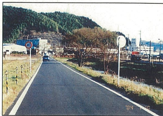
同 左 (鋼橋の上流付近)
