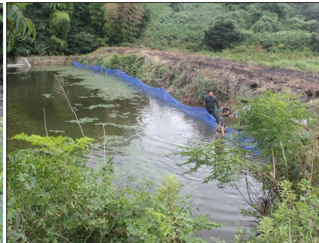
写真 3.2.2 オイルフェンス・ネットの設置事例
