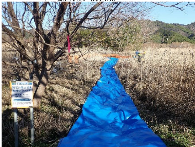
ビニールシートの敷設状況 (搬出路)
