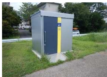
仮設トイレの清掃・維持管理
