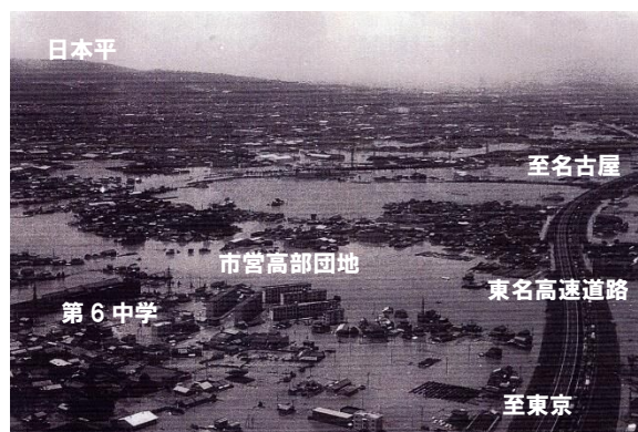
図 3-3. セタ豪雨の浸水状況 (清水区石川新町、天王西、能島) 出典：記念誌「大谷川放水路」
