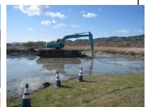
池沼部の掘削（第3工区）
