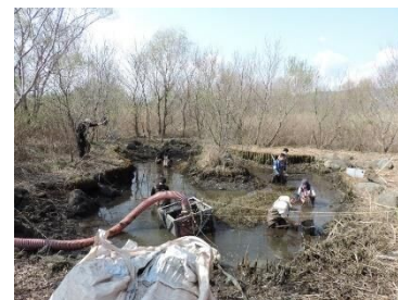
池の水抜きと底泥除去
