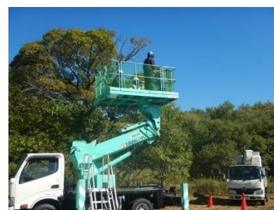
高所作業車体験 (文化シャッター㈱)
