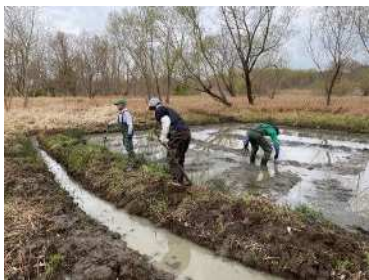
湿地の攪乱作業
