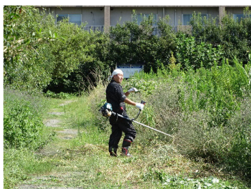
堤防の除草作業
