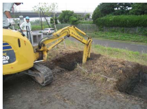
パーゴラの設置作業
