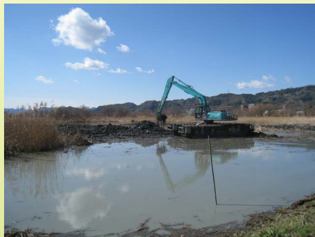
<2014. 2. 7 : 掘削作業状況>
