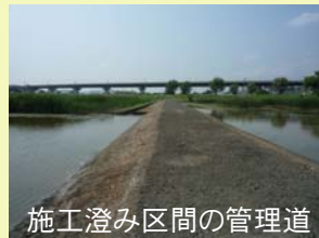
完成した周囲堤と越流堤
