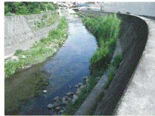
大沢川中流域（追分） 写真・板井
